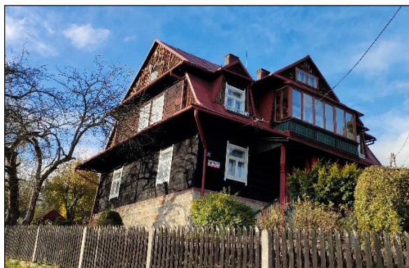
Fot.1. Willa „Sitajka” o konstrukcji drewnianej, zrębowej, przyziemie murowane z kamienia piaszczystego, (Łękawica, ul. Brzozowa)
